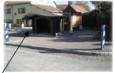
Enduits bicouche Chemin piétonnier (Verjoulot) : 478€
